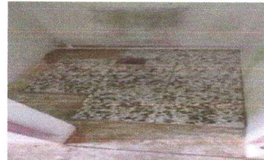
Foto 4: PISO (PISO DE GRANITO)
