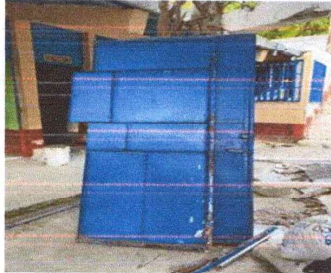
Foto 7: MANTENIMIENTO A PORTONES (REPARACION Y PINTURA).
