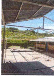
Foto 1: CUBIERTA DE LAMINA (SUSTITUCION LAMINA TROQUELADA CALIBRE 26)
