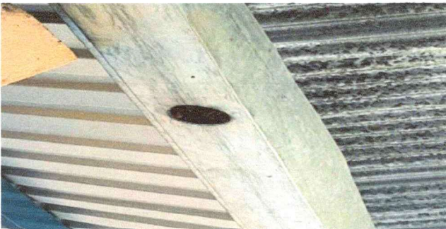
Foto: 5 Cambio de canales y bajada de agua
