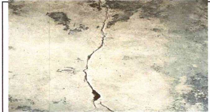
Foto 4: Sustitución a Piso de granito
