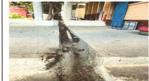
Foto: 6 Demoler y fundir las 2 cunetas
