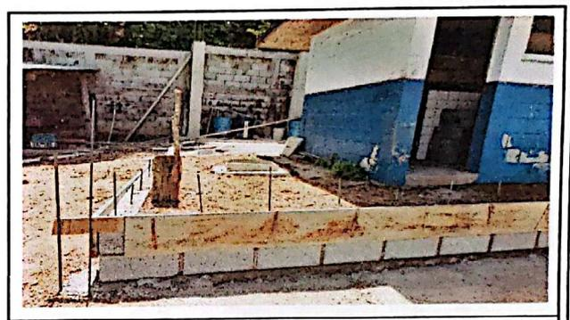
Foto 4: Reparación de Banqueta y caja terminal de drenaje
