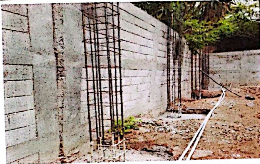
Foto 3: Reforzamiento de muro de Contención
