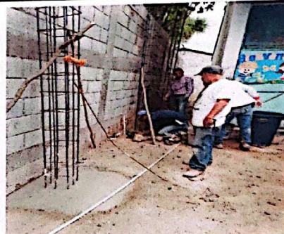
Foto 4: Reforzamiento Muro de Contención
