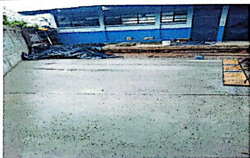
Foto 5: segundo tramo de 25 metros
