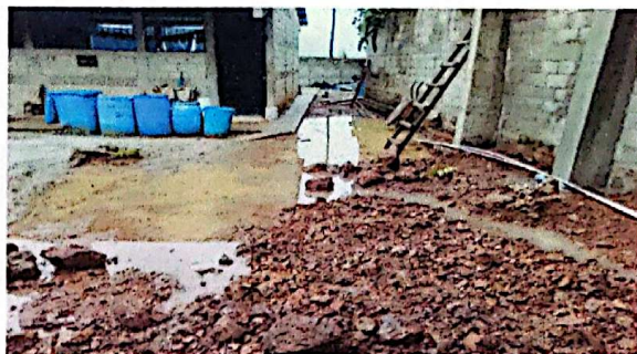
Foto 2: Nivelación del Terreno para loza de patio
