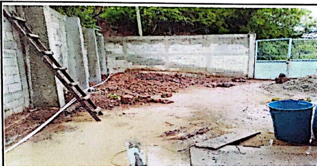
Foto 3: Reparación de muro de Contención
