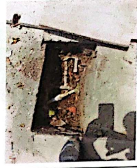
Foto 2: Colapso de Cuneta y Tubería de servicio de Agua
