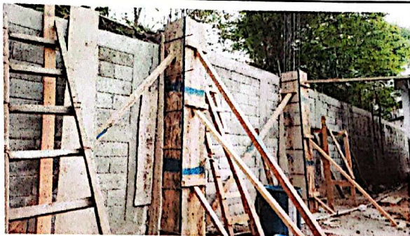
Foto 1: Reforzamiento con columnas de 25X25 a lado del vecino
