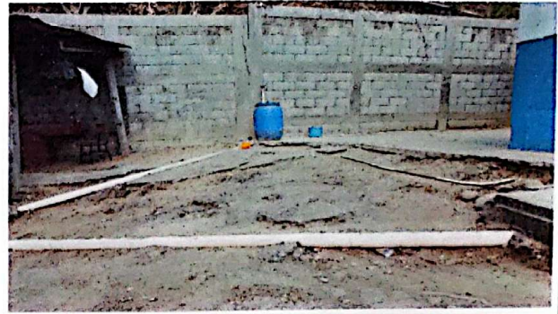
Foto 2: Reparación de sistema de Drenaje
