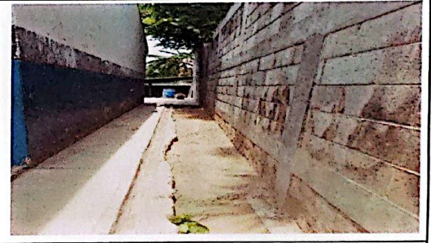
Foto 4: Reforzamiento de Muro de Contención
