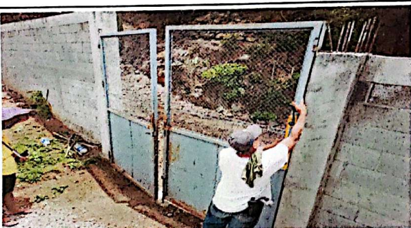
Foto 5: Reparación de Porton entrada Principal
