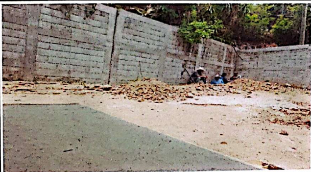
Foto 3: Reforzamiento de muro de Contención
