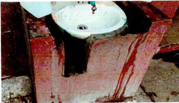
Foto: 5 Cambio de lavamanos por deterioro.
