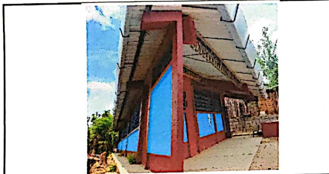
Foto 3: CANALES Y BAJADAS DE AGUA PLUVIAL
