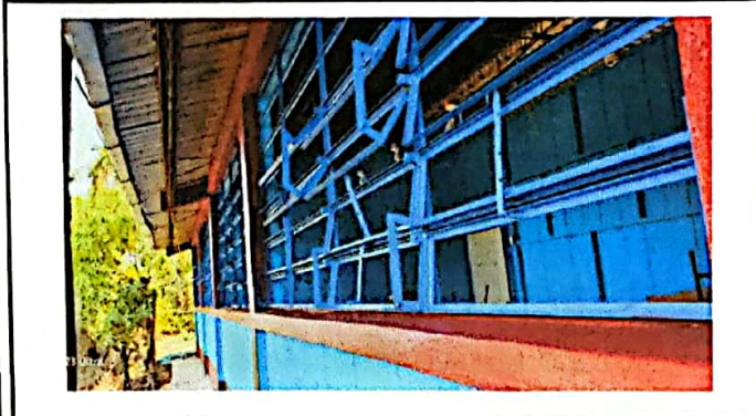
Foto1: Avance de ventanales en proceso
