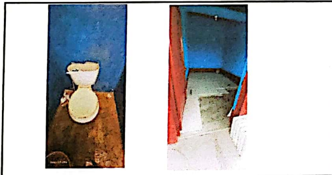
Foto: 5 Avance de servicio sanitario y piso en proceso
