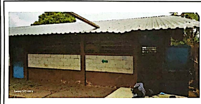
Foto3: Avance de Canales y bajadas de agua en proceso
