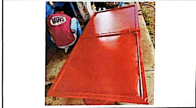
FOTO 2: Avances de puertas en proceso
