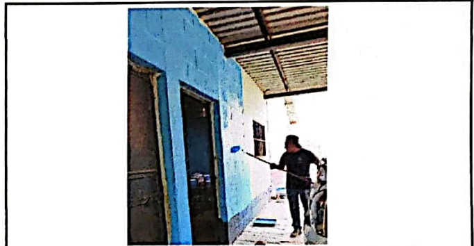
Foto4: Avance de pintura en proceso
