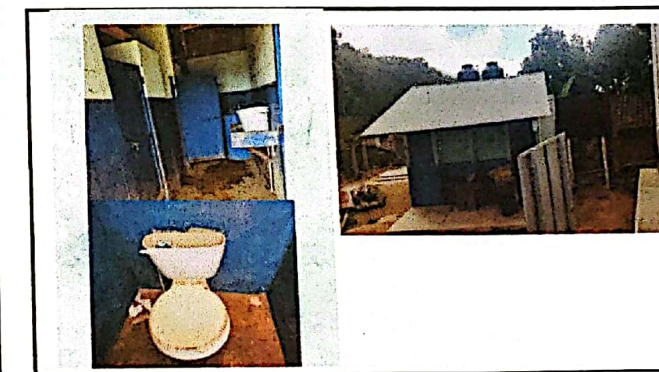
Foto: 6 Servicios sanitarios y sus accesorios
