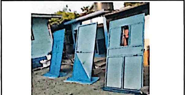
Foto4: Se observa reparación y pintura de puertas.
