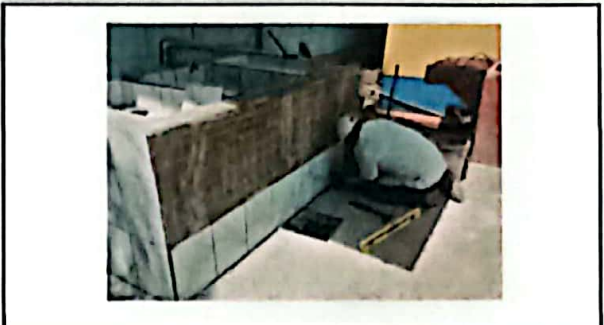
FOTO 2: Reparación de tanque de agua.
