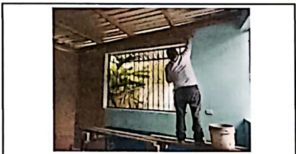
Foto: 6 se evidencia trabajo de repello y cernido de pared húmeda.
