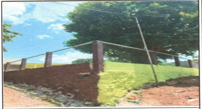
Cernido muro Perimetral
