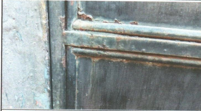
Reparación y pintura para puertas
