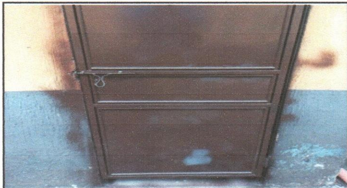
Reparación y pintura para puertas
