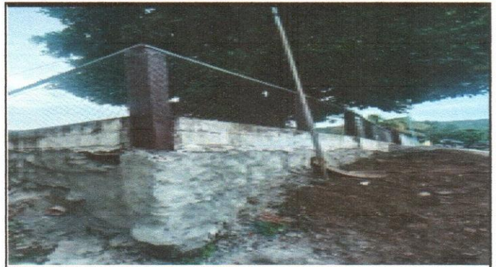
Cernido Muro Perimetral
