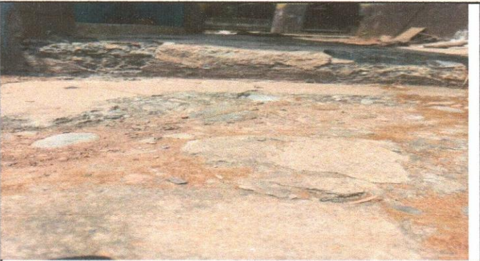
Reparación losa de patio
