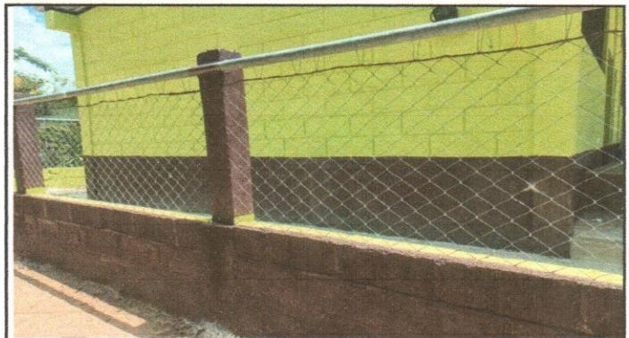
Pintura en muro interior y exteriores
