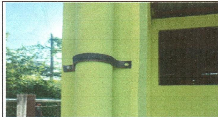
Reparación de canales y bajada de agua pluvial
