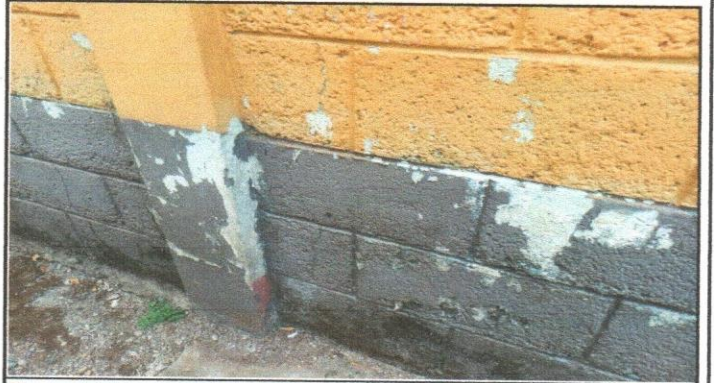
Pintura en muro interior y exteriores
