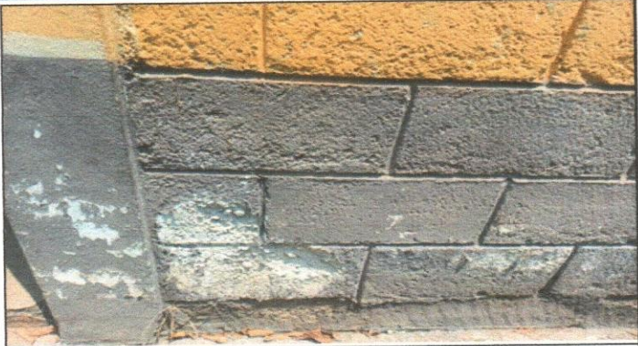
Reparación de repello y cernido de paredes
