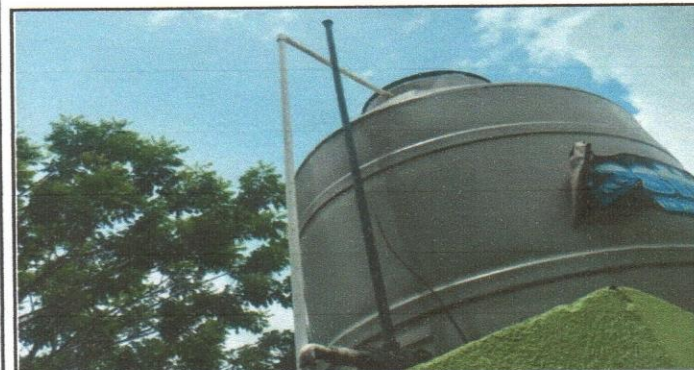
Reparación sistema depósito de agua
