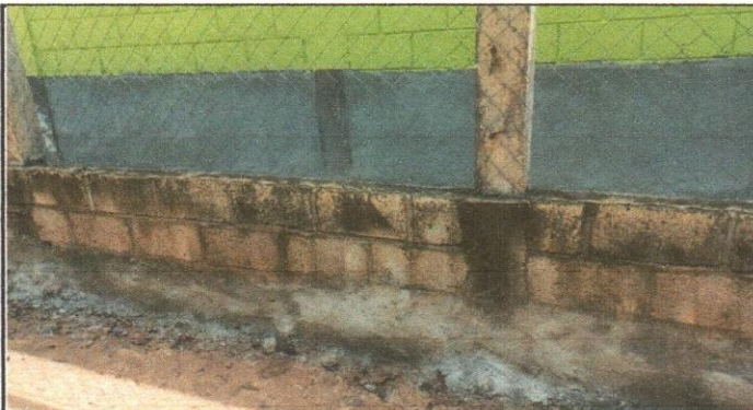
Pintura en muro interior y exteriores
