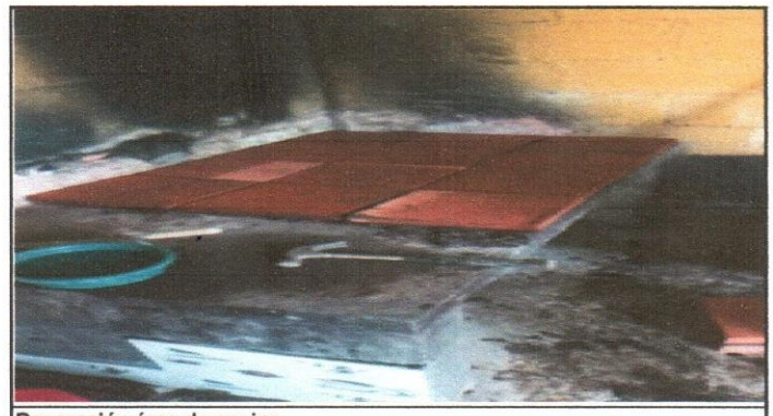
Reparación área de cocina
