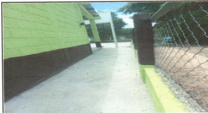
Reparación losa de patio
