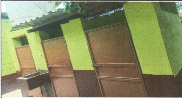
Reparación y pintura para puertas
