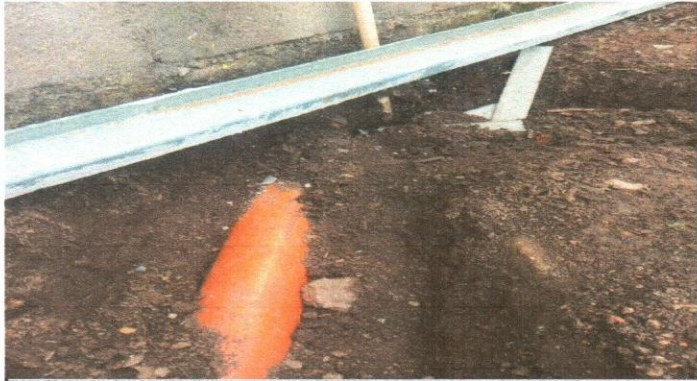
Mantenimiento de Red de Drenaje y Agua Potable
