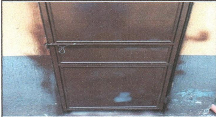
Reparación y pintura para puertas
