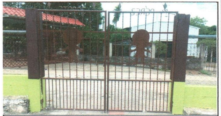
Pintura en porton
