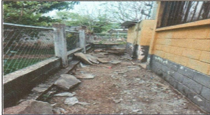
Reparación Losa de Patio
