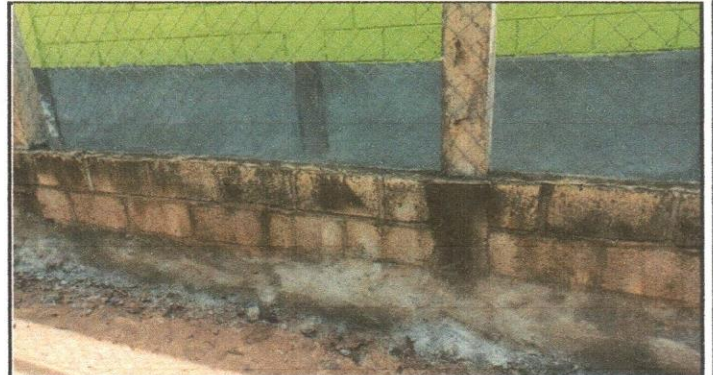
Pintura en muro interior y exteriores
