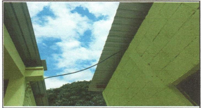
Reparación Sistema Eléctrico
