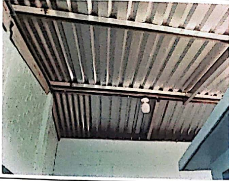
Foto 1: REPARACIÓN DE INSTALACIÓN ELÉCTRICA
