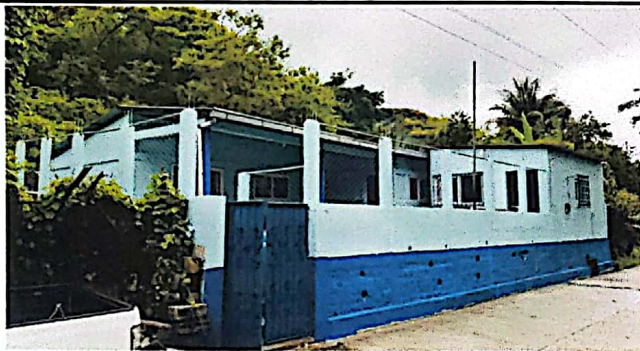
Foto: 5 REPARACIÓN DE MURO PERIMETRAL
