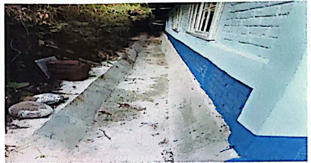
FOTO 2: CUNETA DE CONCRETO
