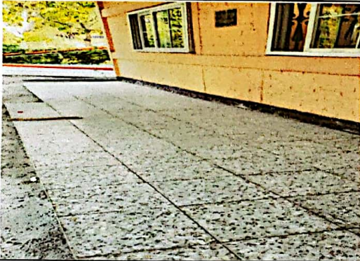
Foto3: CAMBIO DE PISO
