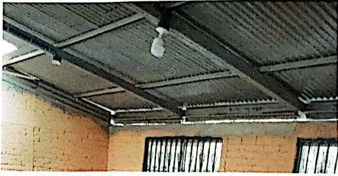
Foto1: REPARACIÓN DE INSTACIÓN ELÉCTRICA
