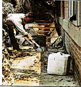
FOTO 2: CUNETETA DE CONCRETO
