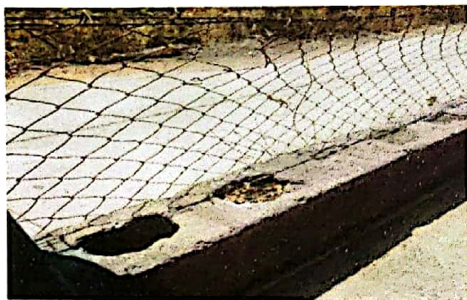
Foto: 5 REPARACIÓN DE MURO PERIMETRAL
