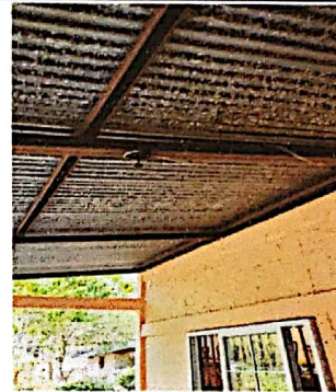
Foto4: PINTURA DE LÁMINA Y ESTRUCTURA
