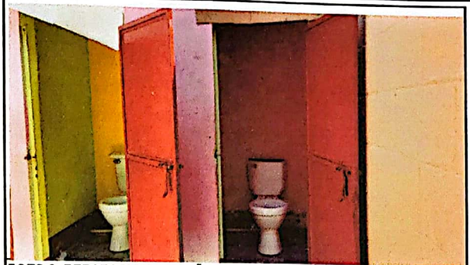
FOTO 2: REPARACION DE BAÑOS Y PUERTAS
