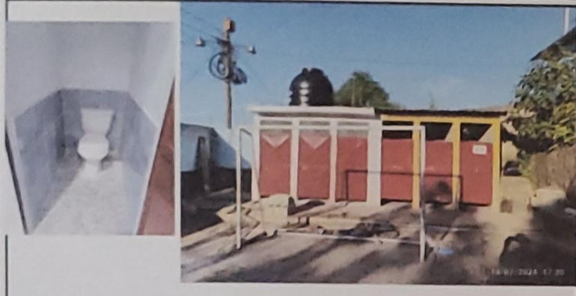
Foto1: REPARACIÓN Y AMPLIACIÓN DE BAÑOS (Incluye reparación de losa, instalación de accesorios inodoro, contra llave, tubo de abasto, kit de tanque y puertas)
