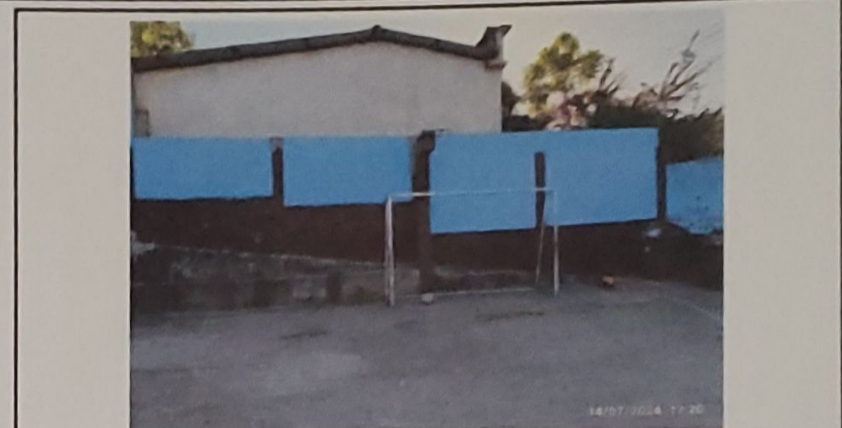
Foto 2: REPARACIÓN DE MURO PERIMETRAL
