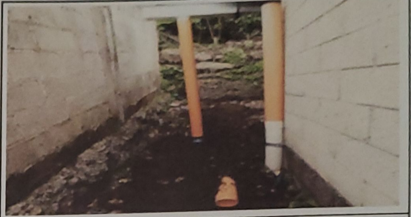
Foto 2: INSTALACION DE CANAL Y BAJADA DE AGUA PLUVIAL
