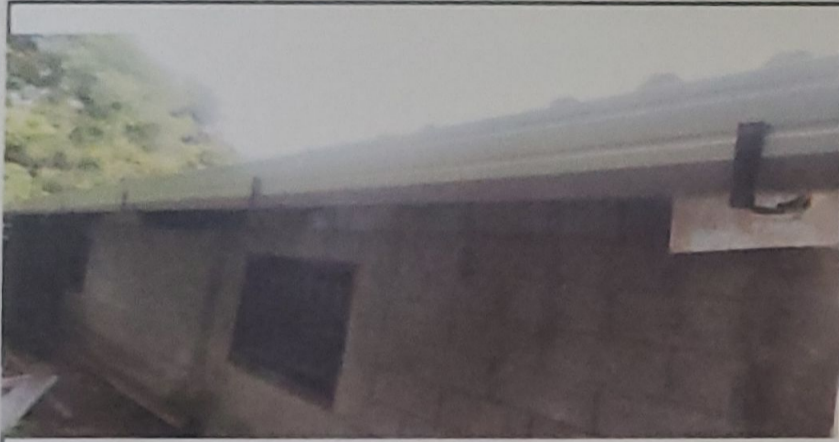
Foto 1: INSTALACION DE CANAL Y BAJADA DE AGUA PLUVIAL
