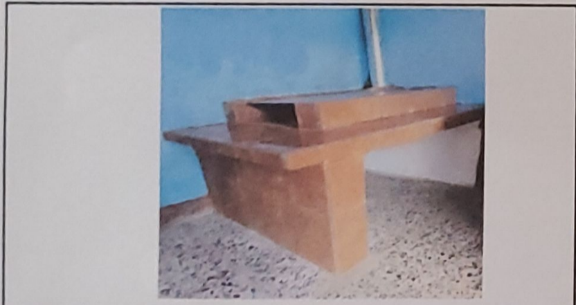
Foto 3: REPARACIÓN DE AREA DE COCINA (Incluye Instalación de estufa rural (completa) Incluye chimenea y plancha de metal, plla, reparación de paredes, losa en piso)
