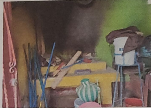
FOTO 2: REPARACION AREA DE COCINA
