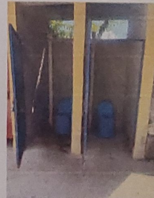
Foto: 6 REPARACIÓN Y AMPLIACIÓN BAÑOS
