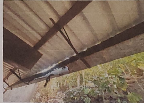
Foto4: INSTALACIÓN DE CANAL Y BAJADA DE AGUA PLUVIAL
