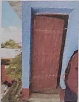
Foto3: REPARACIÓN DE PUERTAS
