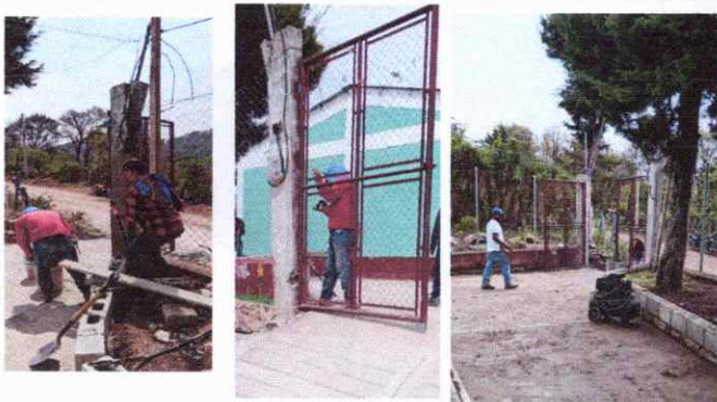
Foto 3: SE LE DARA MANTENIMIENTO AL PORTON DE INGRESO MEDIANTE PINTURA ANTICORROSIVA.
