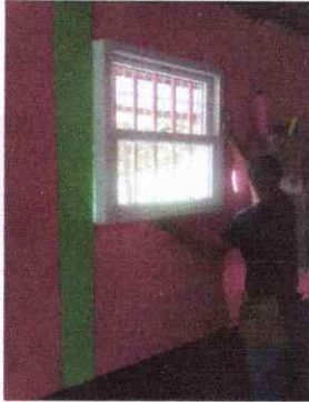
Foto 1: INSTALACION DE VENTANA.
