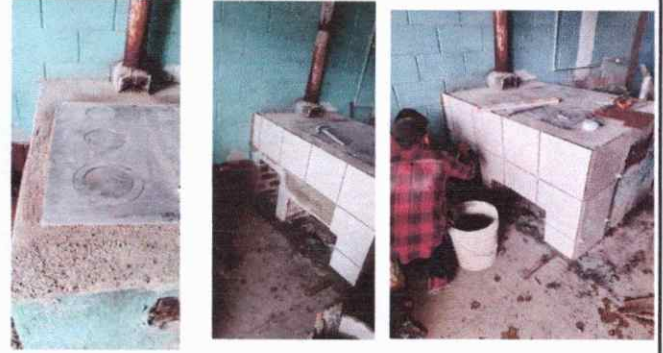
Foto 8: REPARACION (ESTUFAS RURALES, PILAS, CHIMENEAS, ETC.)
