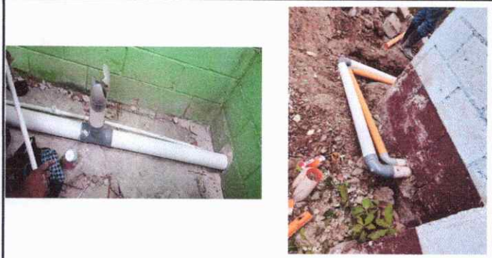
FOTO 2: INSTALACION DE TUBERIA PARA LA INSTALACION DE LOS NUEVOS BAÑOS.
