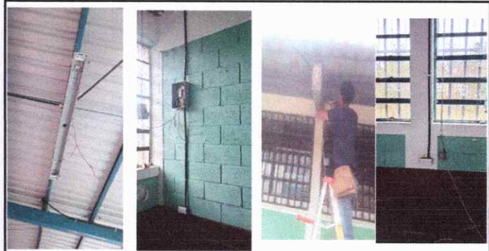
Foto 6: REPARACION DE SISTEMA DE ILUMINACION DUCTOS Y CABLEADOS Y LAMPARAS
