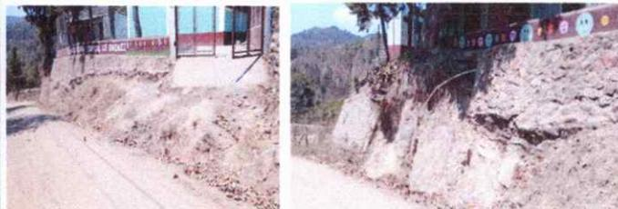
**Foto 10: REBOSTIMIENTO DE CONCRETO EN TALUD CON ELECTROMALLA Y ENSABIETADO A LA SUPERFICIE DEL TERRENO NATURAL.**
