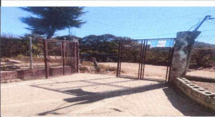
Foto 3: SE LE DARA MANTENIMIENTO AL PORTON DE INGRESO MEDIANTE PINTURA ANTICOROSIVA.
