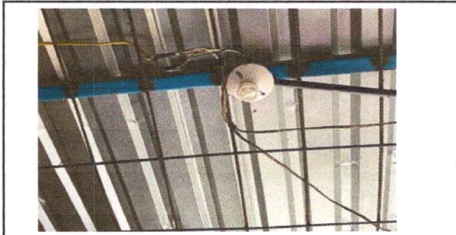
Foto 10: REPARACION DE SISTEMA ELECTRICO (Reparación)
