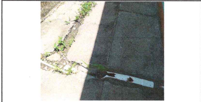
FOTO 7: REPARACIÓN DE RED DE DRENAJES Y RED DE AGUA POTABLE (Sustitución)
