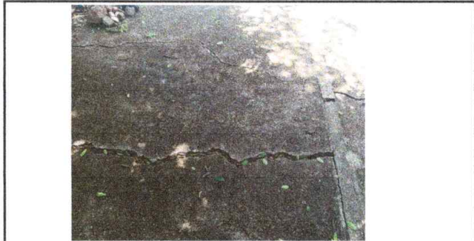
Foto 9: LOSA DE PATIO (Sustitucion, base, fundición y acabado)
