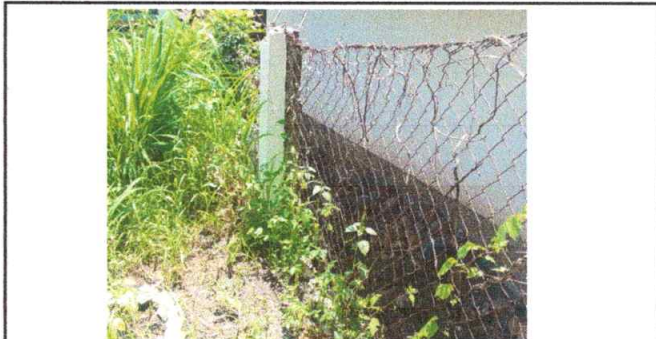
FOTO 8: CERCO O MURO PERIMETRAL (Reparación block con malla)
