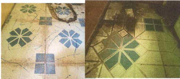
Foto 3: PISO (Sustitución piso cerámico)
