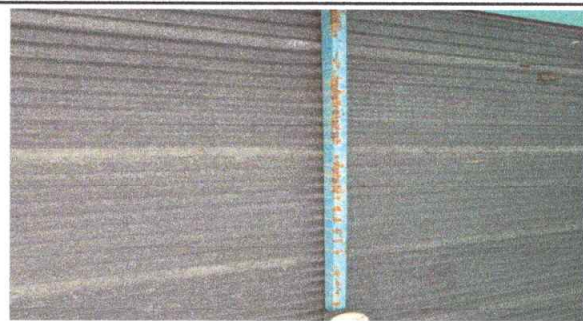
FOTO 2: ESTRUCTURA DE TECHO REPACCIÓN Y MANTENIMIENTO
