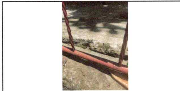
Foto 5: Mantenimiento a barandas
