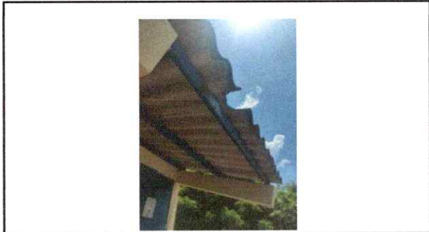
Foto 2: Estructura de techo
