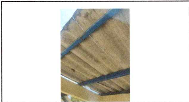
Foto 1: Cubierta de lamina
