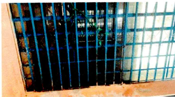
Foto 4: pintura y soldadura de balcones
