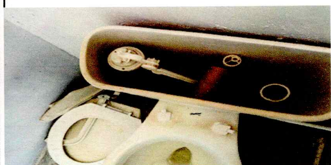
Foto 3: Cambio de sanitarios y mijtorios
