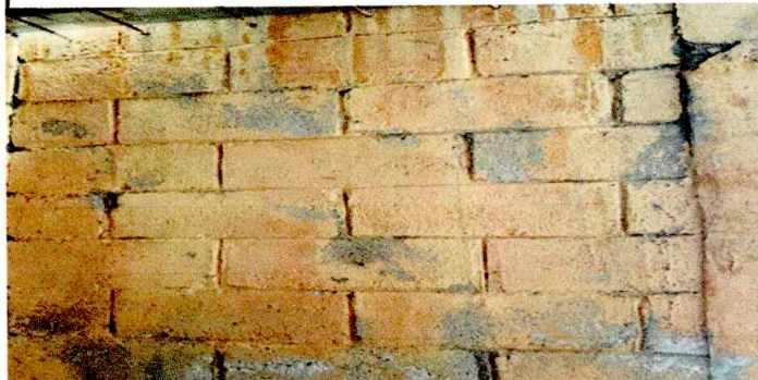
FOTO 2: Pintura en toda la escuela dentro y fuera, paredes y muros
