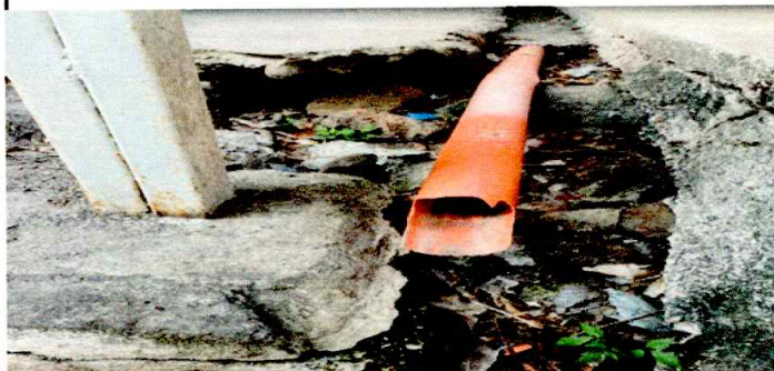
Foto: 5 Cambio de red de drenaje y arreglo de tubería de agua potable
