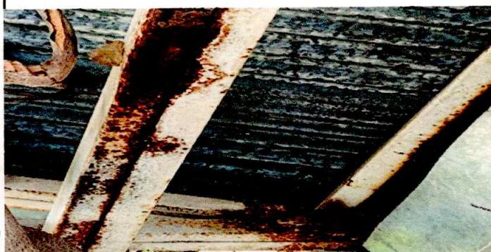
FOTO 1: Desmontar, pintar y cambiar las tijeras que no esten buenas
