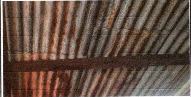
Foto 2: SUSTITUCIÓN ESTRUCTURA DE TECHO
