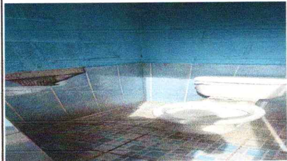
Foto 8: SUSTITUCIÓN DE AZULEJOS
