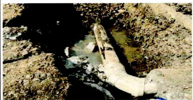
Foto 5: SUSTITUCIÓN DE DRENAJE Y RED DE AGUA POTABLE
