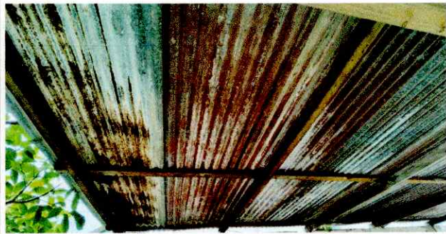
Foto1: SUSTITUCIÓN DE LAMINA
