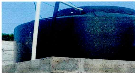
Foto 9: SUSTITUCIÓN DE ROTOPLAS
