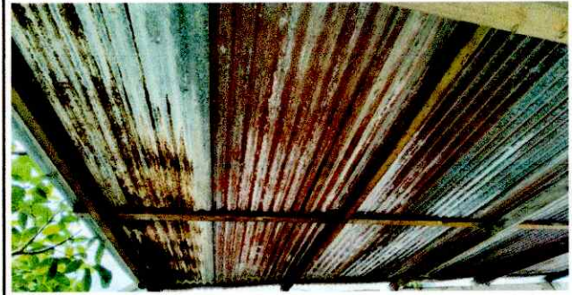
Foto 2: SUSTITUCIÓN ESTRUCTURA DE TECHO
