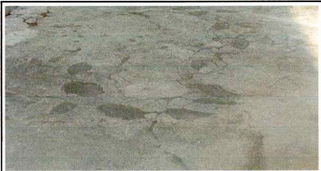
Foto 7: LOSA DE PATIO
