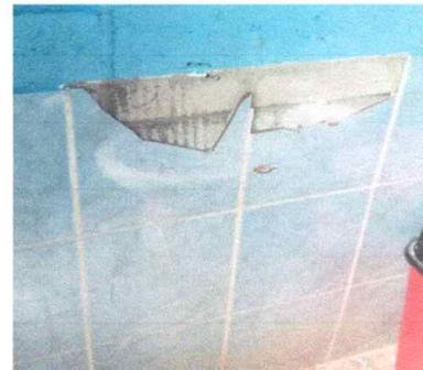
Foto 6: Se observa azulejo de sanitarios en mal estado.
