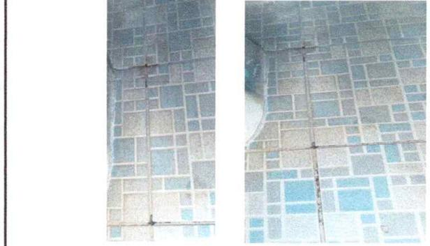
FOTO 2: Se evidencia piso ceramico en sanitarios en mal estado.
