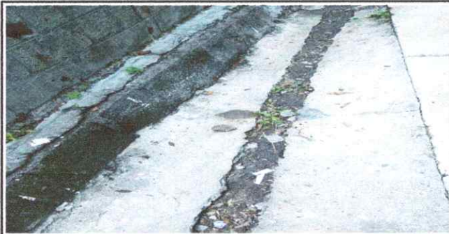
Foto 5: CUNETA DE CONCRETO
