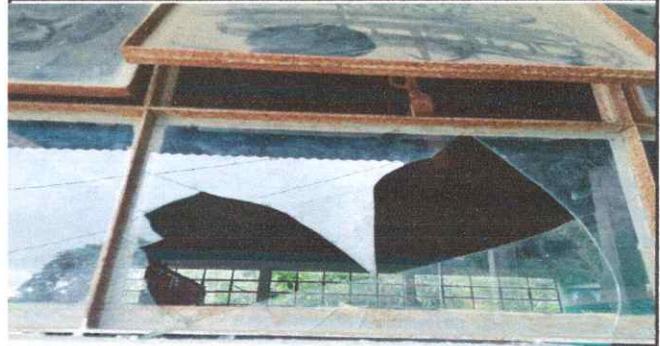
Foto 4: SUSTITUCIÓN DE VENTANAS
