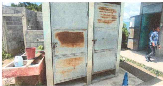
Foto 3: REPARACIÓN, SUSTITUCIÓN Y MANTENIMIENTO DE PUERTAS
