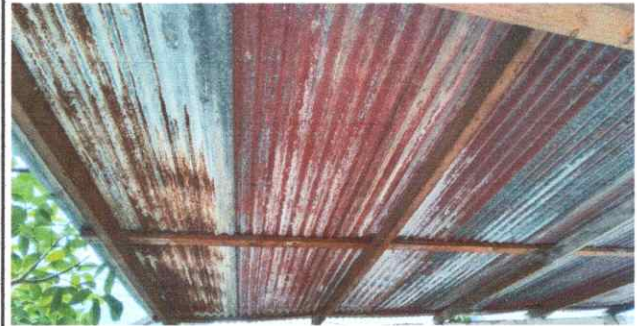
Foto 2: SUSTITUCIÓN ESTRUCTURA DE TECHO
