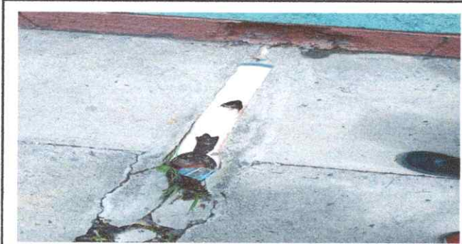
Foto 7: REPARACIÓN DE DRENAJE Y AGUA POTABLE
