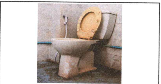
Foto 5: cambio de sanitario por deterioro
