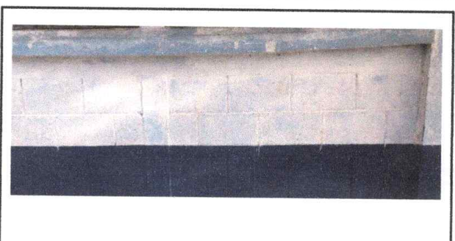
Foto 4: pintura en muros interiores y exteriores por deterioros
