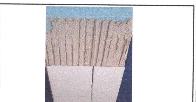
Foto 6: Cambio de azulejo por deterioro en los sanitarios
