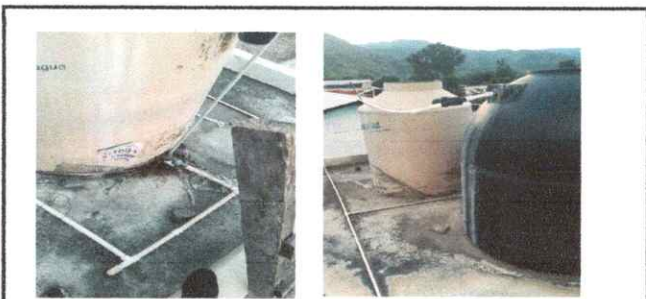
Foto 5: Sistema de distribucion de agua en mal estado y para evitar humedad se le colocaran tayuyos.
