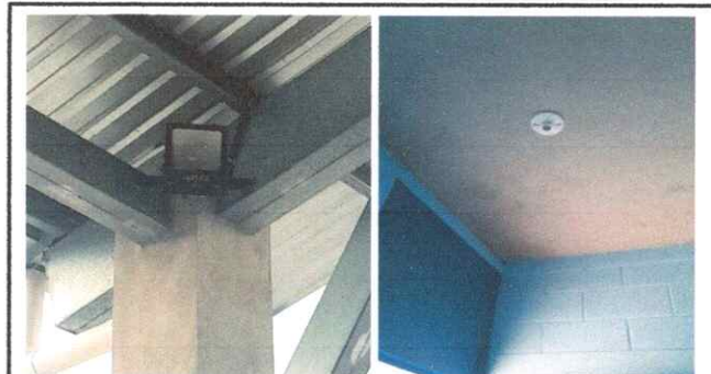
Foto 4: Se sustituiran las lamparas quemadas
