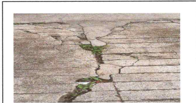
Foto 9:SE OBSERVA LOSA DE PATIO EN MAL ESTADO .
