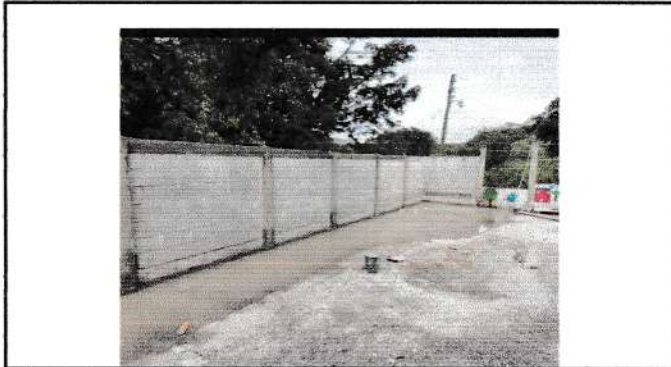
Foto 3: Muro perimetral finalizado.
