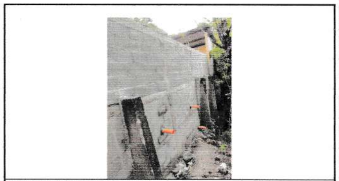
Foto 6: Muro perimetral finalizado.
