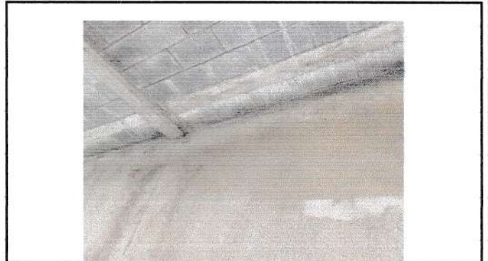
Foto 4: Loza de patio finalizada.
