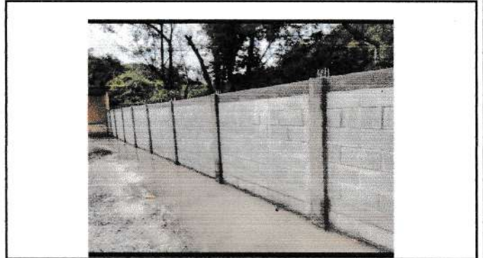
Foto 2: Muro perimetral finalizado.
