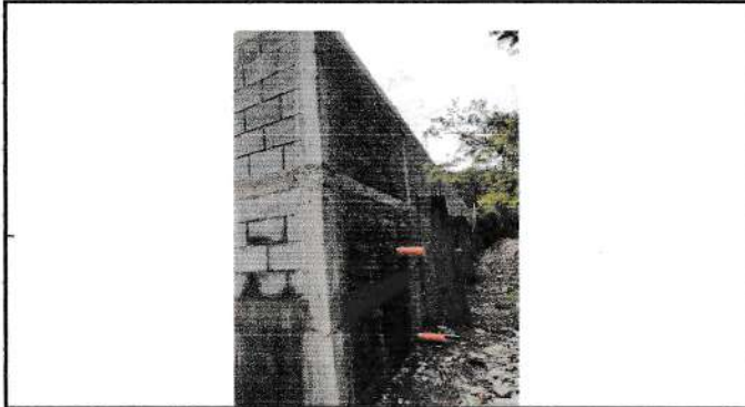
Foto 1: Muro perimetral finalizado.
