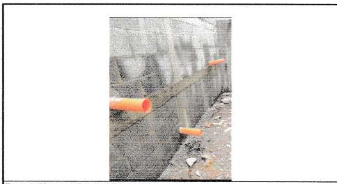
Foto 5: Muro perimetral finalizado.
