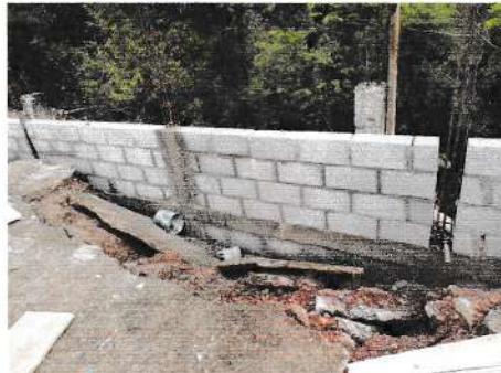
Foto 3: Avance del muro perimetral en proceso.
