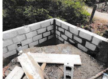
Foto 2: Avance del muro perimetral en proceso.
