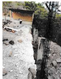
Foto 6: Avance del muro perimetral en proceso.
