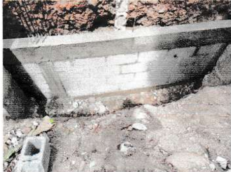
Foto 1: Avance del muro perimetral en proceso.
