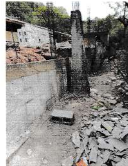
Foto 4: Avance del muro perimetral en proceso.
