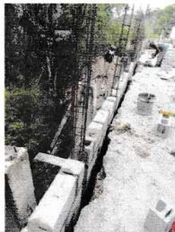
Foto 5: Avance del muro perimetral en proceso.
