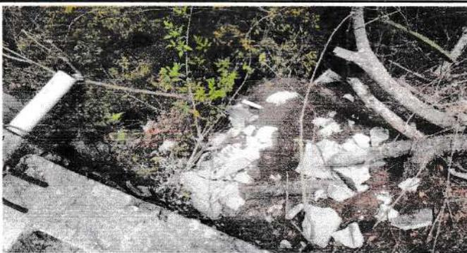
Foto3: Desprendimiento de muro perimetral
