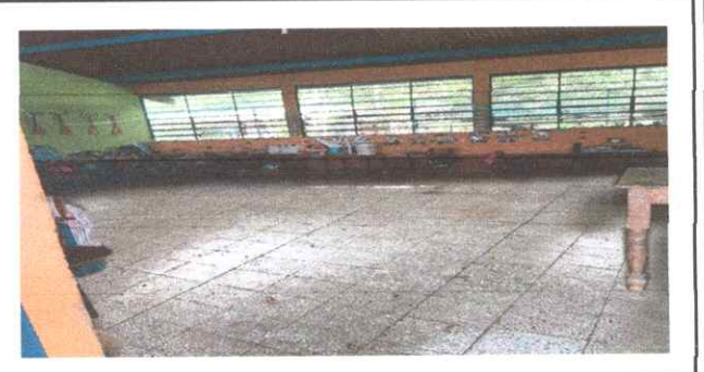
Foto 2: SUSTITUCIÓN PISO GRANITO AULA 2
