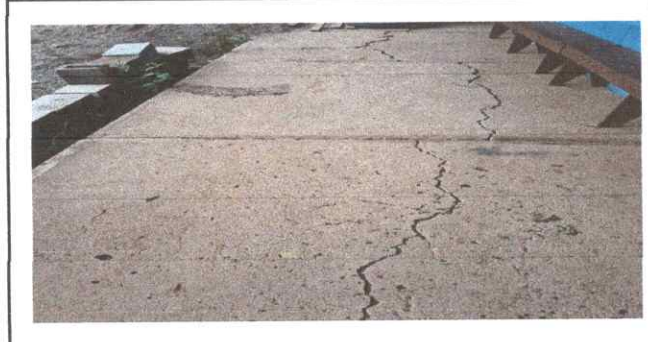
Foto 3: LOSA DE PATIO
