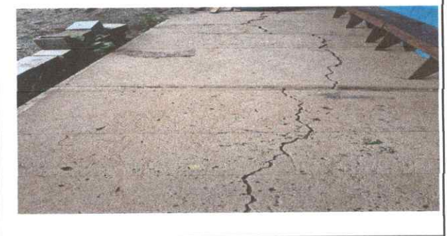
Foto 4: LOSA DE PATIO
