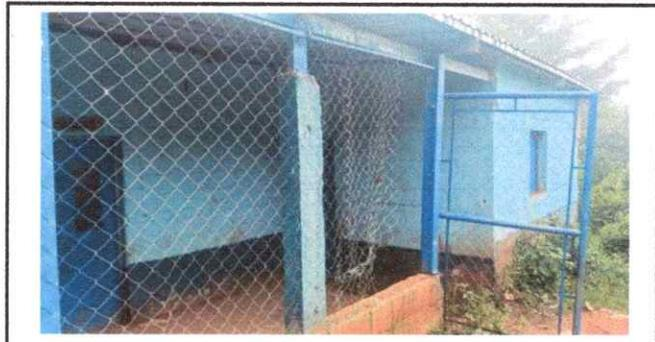
Foto 2: SUSTITUCIÓN DE CERCO PERIMETRAL CON BLOCK Y MALLA
