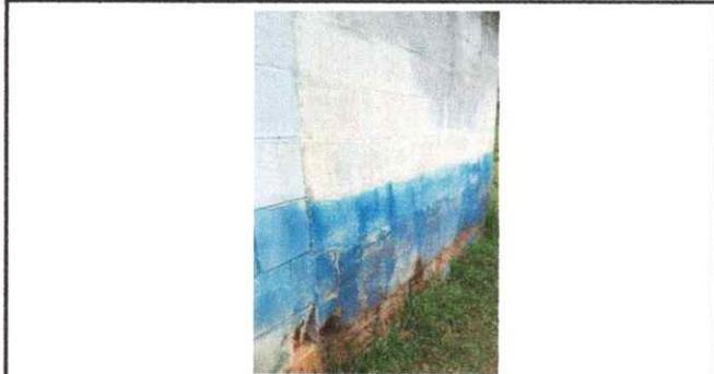
Foto 3: IMPERMEABILIZACION POR SELLADOR TIPO PINTURA
