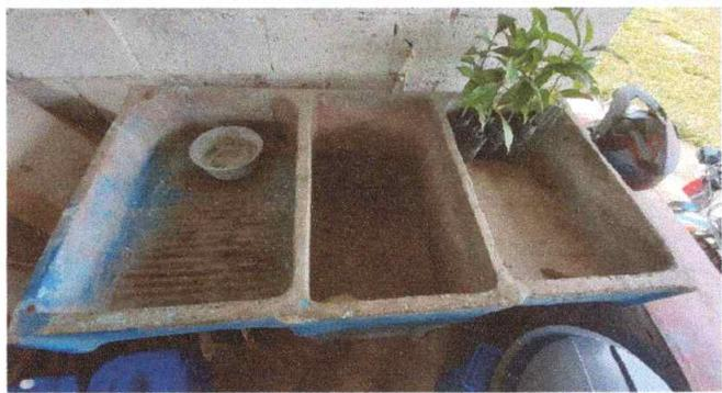
Foto 13: SUSTITUIR PILA (ÁREA DE COCINA). DEBIDO A DETERIORO, NO RETIENE EL AGUA LIMPIA Y DUCTOS DE DESECHO TAPADOS.
