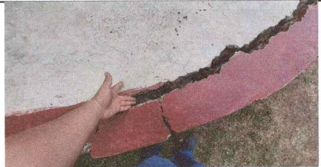
Foto 10: SE PUEDE APRECIAR LA SEPARACIÓN EN LOSA POR EL MAL ESTADO.
