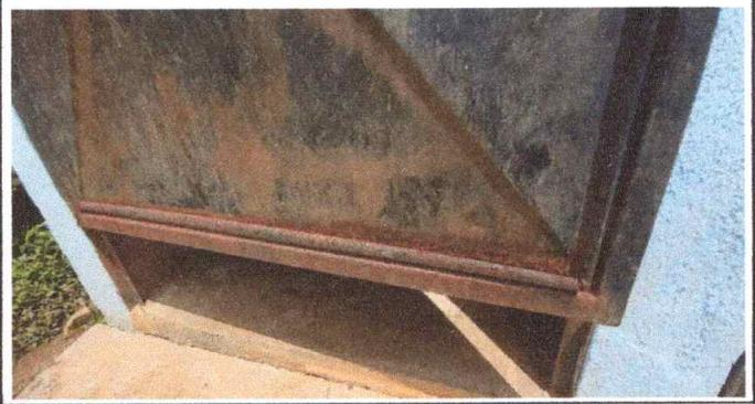
Foto 2: MANTENIMIENTO A PUERTAS DE BAÑOS (PINUTURA) DETERIORO POR CORROSIÓN.
