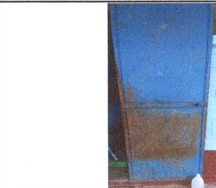
Foto 3: MANTENIMIENTO A PUERTAS DE AULAS (PINUTURA) DETERIORO POR CORROSIÓN.
