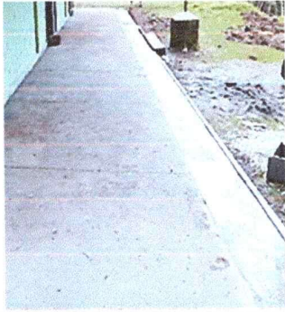
Foto7: cambio de losa de patio (incluye base)
