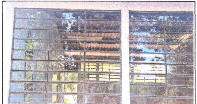
Foto 4: Se instaló ventanas en aula
