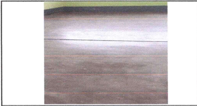
Foto: 5: se sustituyó el piso de concreto en aula
