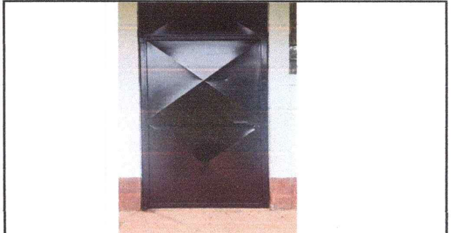
FOTO 2: Se instaló puerta en aula
