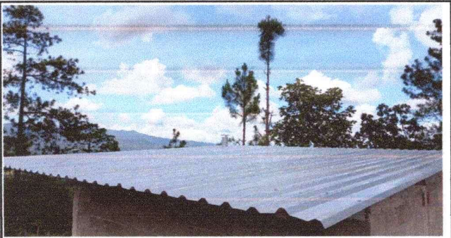
Foto1: CUBIERTA DE LAMINA DE FIBROCEMENTO A LAMINA TROQUELADA CALIBRE 26
