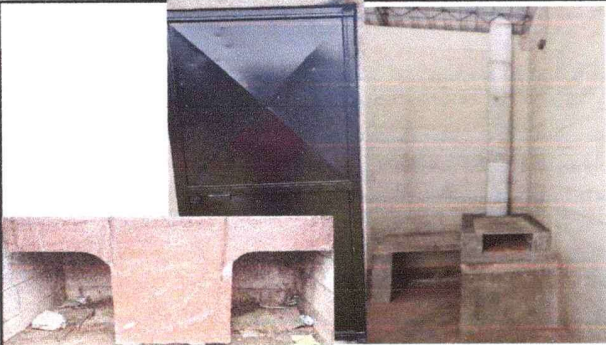
Foto 9: sustitución de cocina
