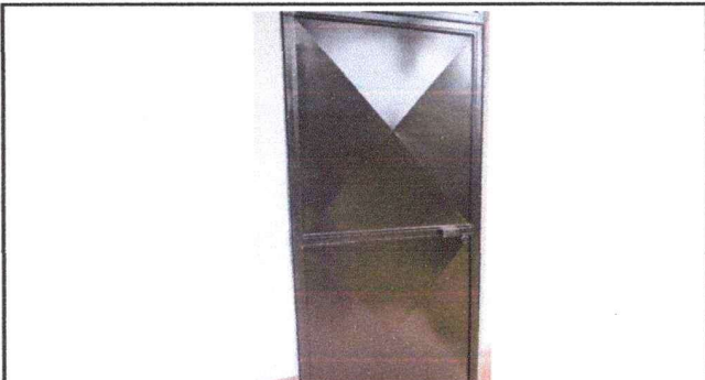
Foto3: se instaló puerta en baño
