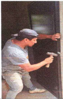
Foto3: instalación de puerta en baños
