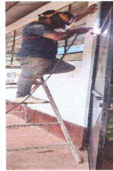
FOTO 2: Instalación de puerta en aula
