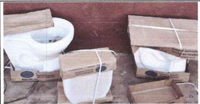
Foto: 6 sustitución de sanitarios y sus accesorios
