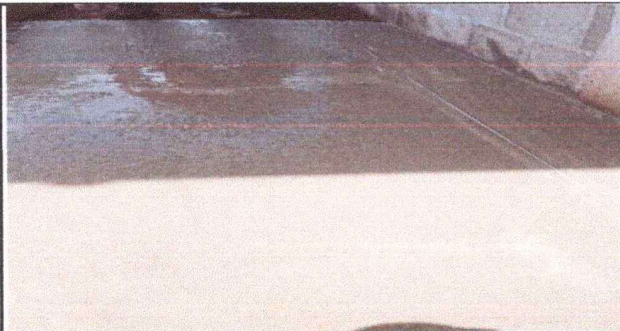
Foto: 5 sustitución de piso de concreto de aula
