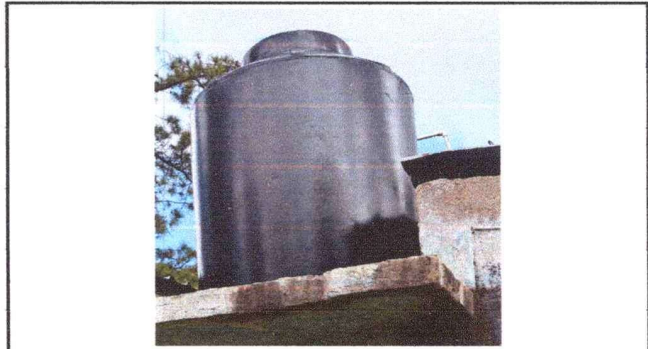
FOTO 8: Sustitución de tinaco
