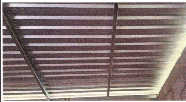
Foto1: sustitución de techo
