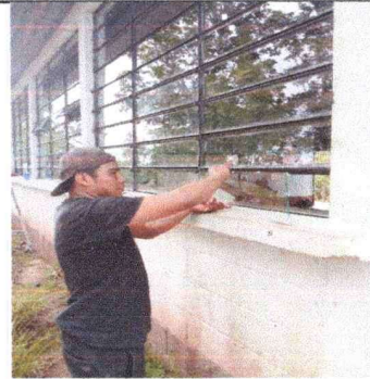
Foto4: sistitución de ventanales
