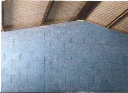
Foto 1: Sustitución de pintura base agua
