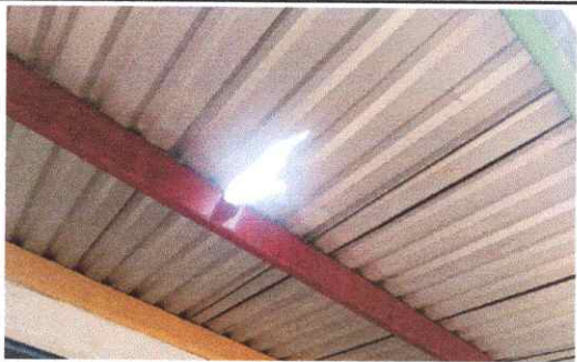
Foto 3: Sustitución lamina troquelada calibre 26
