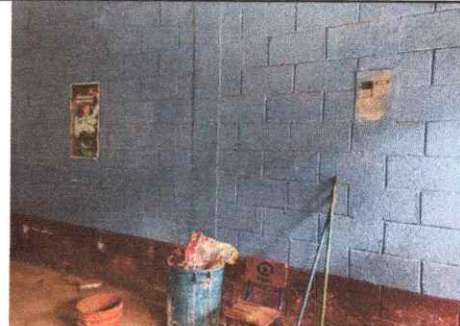
Foto 2: Sustitución de pintura base aceite (zocalo)
