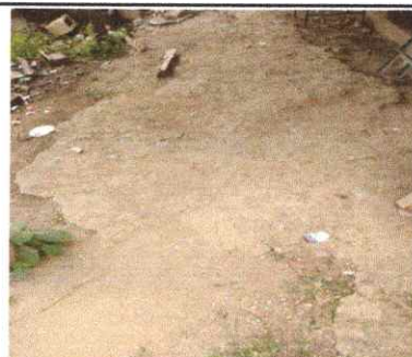
Foto 4: Sustitución losa de patio
