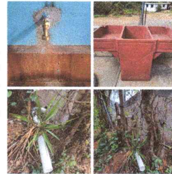
Foto 6: reparación de drenaje finalizado
