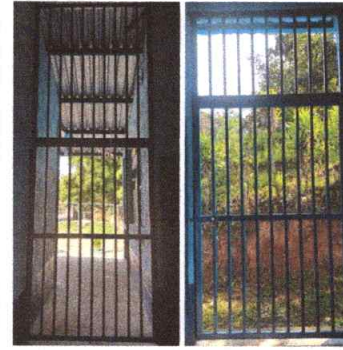
Foto 2: puertas de baños reparadas
