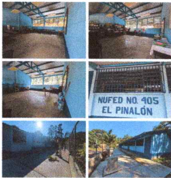
Foto 3: pintura interior y exterior finalizado
