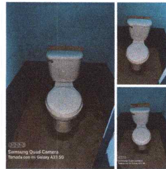
Foto 4: sustitución de servicios sanitarios finalizado
