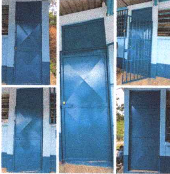
Foto 1: puertas de aulas reparadas
