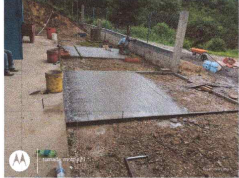
Foto 2: losa de patio sustitucion
