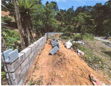
Foto 1: cerco o muro perimetral (block mas malla)
