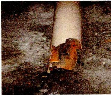
Foto 3: SE OBSERVA LA BAJADA DE AGUA PLUVIAL EN MAL ESTADO
