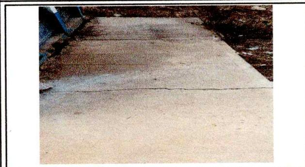
Foto 7: LA LOSA DE PATIO SE ESTA DETERIORANDO Y NECESITA CAMBIO
