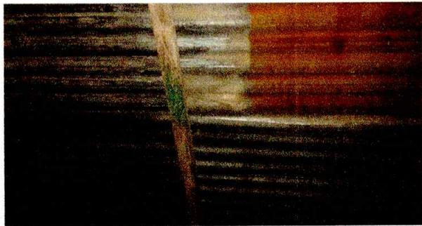
Foto 1: SE VE EN MAL ESTADO LA LAMINA DE LA COCINA
