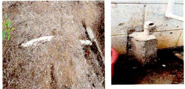
Foto 6: ESTADO DE LA TUBERIA DE DRENAJE, NECESITA CAMBIO.
