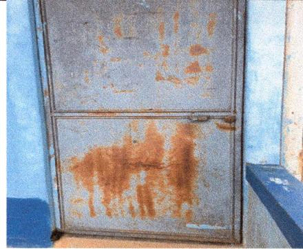
Foto 2: Mantenimiento a puerta de metal lijado, cepillado, sujeciones, aplicación de 2 manos de pintura anticorrosiva) 3.30\*1.00
