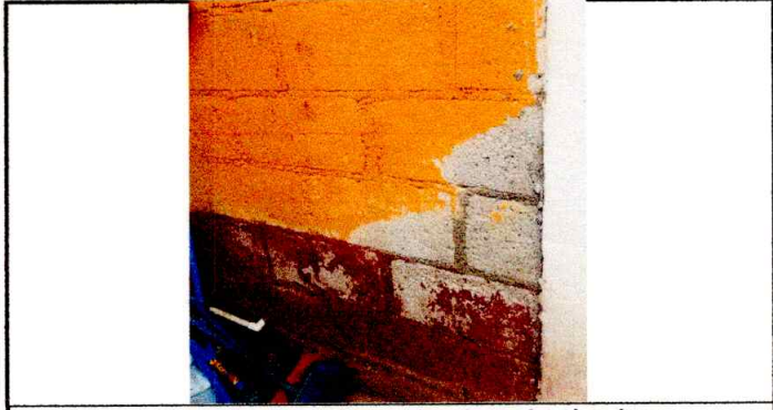
Foto 6: Pintura de paredes interiores y exteriores deterioradas.
