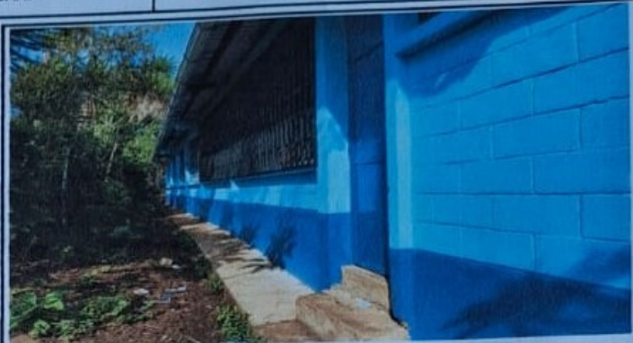
FOTO 2: En esta imagen se evidencia terminado el proceso de repello, pintado de muro exterior, pintado de los valcones, canal y pintado de puertas.
