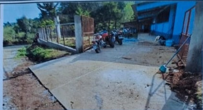
Foto 1: En esta imagen se evidencia el terminado del proceso de la losa de patio, la reparación del muro perimetral y la reparación del porton.
