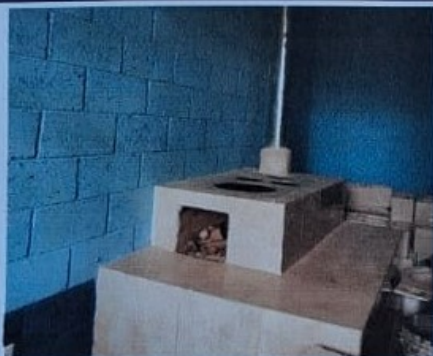
Foto 3: En esta imagen se evidencia culminada la reparación de la plancha de la coina.
