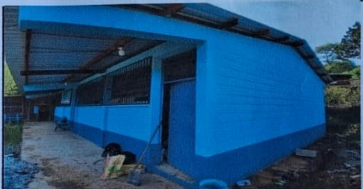
Foto 4: En esta imagen se evidencia el proceso de pintado en muros exteriores e interiores culminado así como el sistema eléctrico, la pintura en puertas y valcones.
