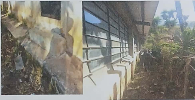
Foto3: Reparación y limpieza de cuneta
