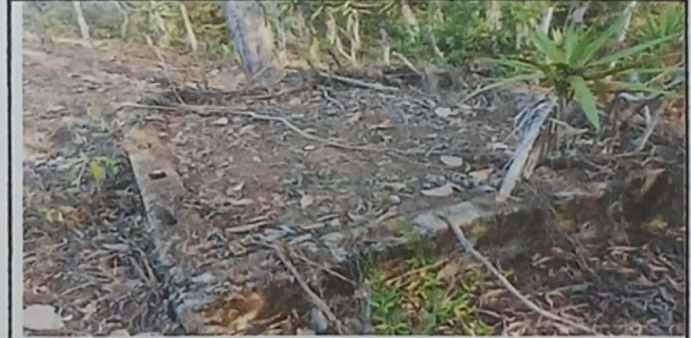
Foto: 12: Recuperación de tanque para guardar agua.
