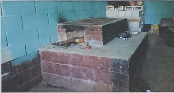
Foto1: Reparación de plancha, cambio de plancha, chorro, pila, colocación de la chimenea y repintado de muros.
