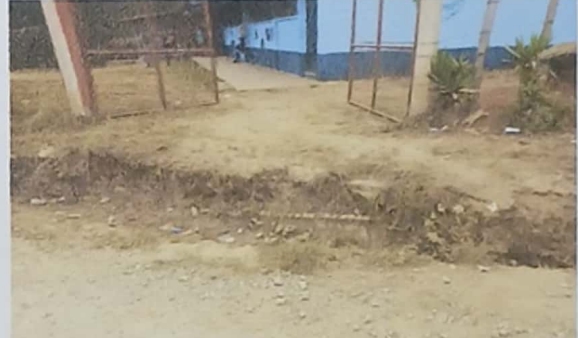
Foto4: Reparacion de cuneta en entrada al NUFED.
