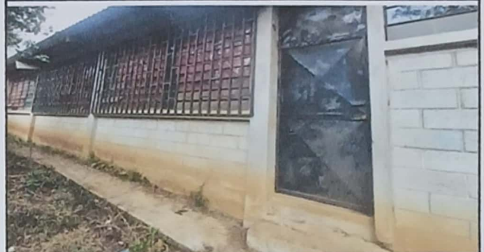
FOTO 2: Colocar canal, repello a un metro del piso, reparacion de losa, repintado de puertas y balcones.
