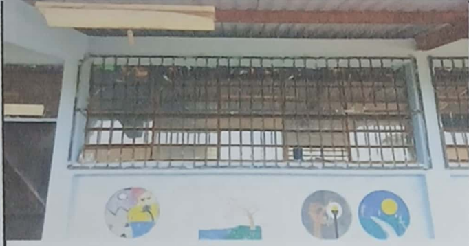
Foto 7: Repintado de balcones y reposición de vidrios quebrados.
