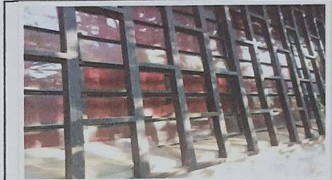
FOTO 8: Repintado de balcones y reposición de vidrios quebrados.
