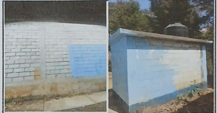
Foto9: Repintado de muros exteriores y baños.
