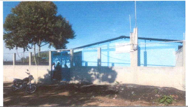
Foto 2: Muro Perimetral Mas Malla finalizado
