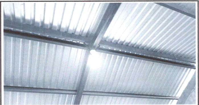
Foto 4: Focos Nuevos ya instalados
