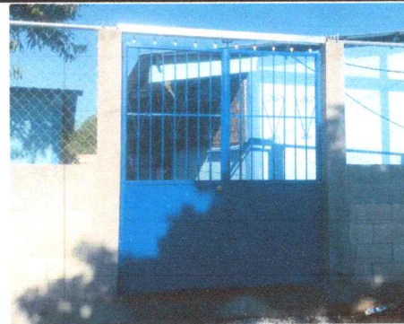
Foto 6: Portón nuevo Instalado
