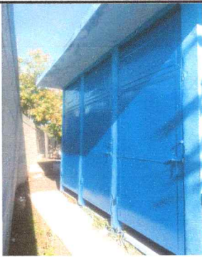
Foto 5: Reparación y Pintura de Baños ya finalizada
