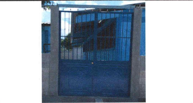
Foto 6: Portón ya Instalado
