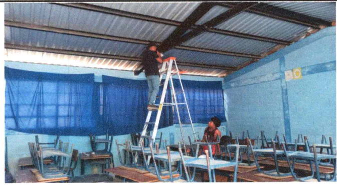
Foto 4: Cambiando Focos en mal estado
