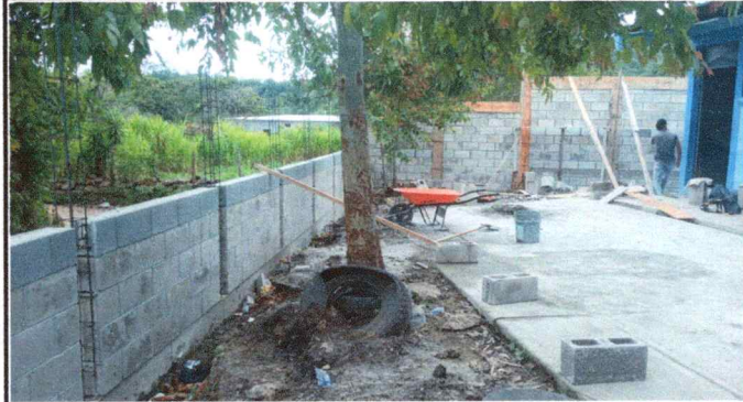
Foto 1: Muro Perimetral ya en Proceso de Construcción
