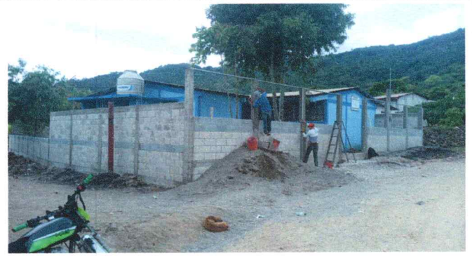
Foto 2: Muro Perimetral Mas Malla en Proceso
