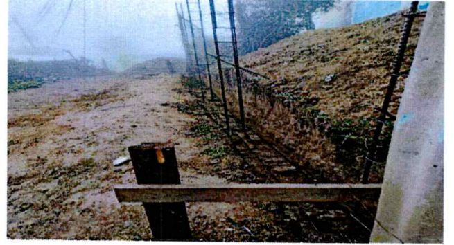
Foto 2: Sustrucción de muro de contención
