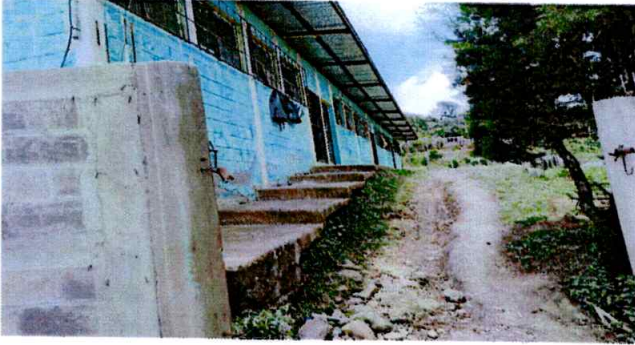
Foto 1: Sustrucción de portón
