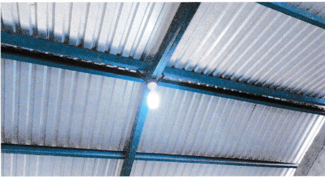
Foto 3: Foco y plafonera nueva salón 1.
