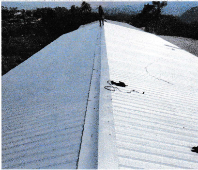
Foto 5: Inspeccionando el techado.
