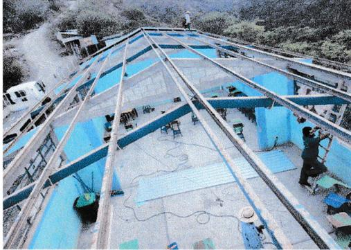
Foto 1: Inicio de montaje de lámina
